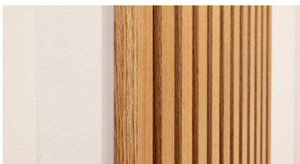
リブパネルの左右いずれかの片端は、シンプルタイプで10mm幅と奥行き部分のベニヤ材、デラックスタイプで20mmの基部が見えます。エンドは、片端を木目で美しく仕上げたい時に追加で取り付けることを推奨しています。
